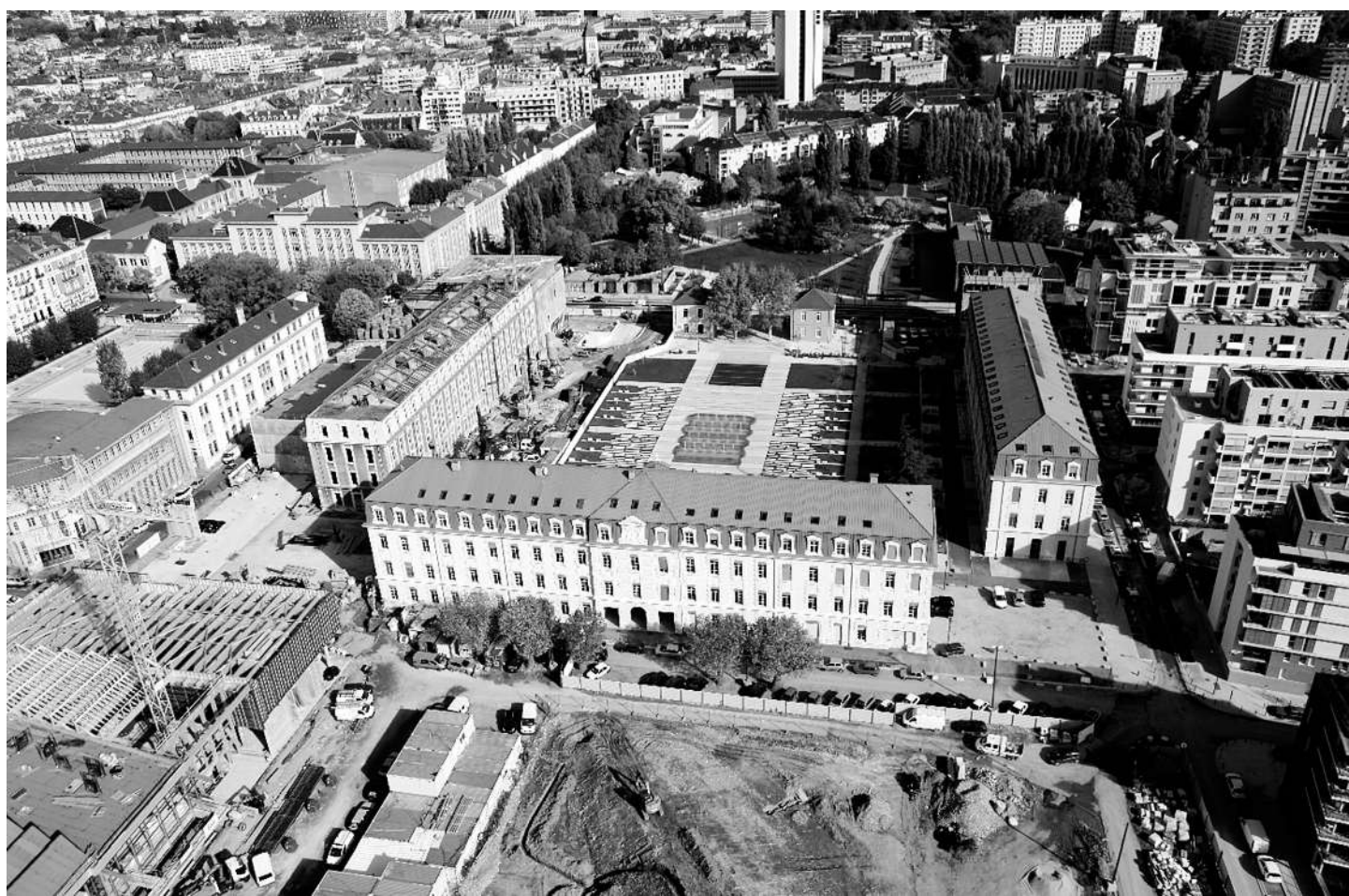
En 2003, l'ambition énergétique de la reconversion de ce centre-ville était sans égale en France. THIERRY CHENU/VILLE DE GRENOBLE
